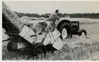
Auf Kufen gleitet der federnd aufgehängte Aufgreifer über den Boden und paßt sich Unebenheiten selbsttätig an. Idealer Trommel-Durchmesser und gesteuerte Federzinken garantieren absolut saubere Aufnahme auch bei feuchten oder sehr kurzen Halmen. Der gesteuerte Zubringer fördert das Preßgut direkt in den Preßkanal.
